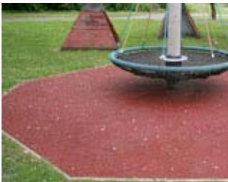
Bild 29, Gummibeläggning Utan fogar.
