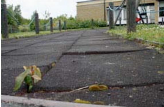
Bild 27, Äldre fallskyddsplattor.
